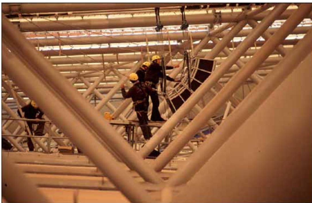
屋根の中へのラインアレー設置
