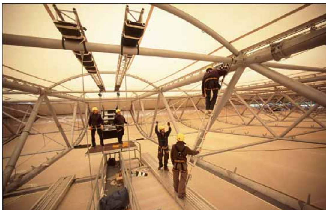
屋根の中へのラインアレー設置
